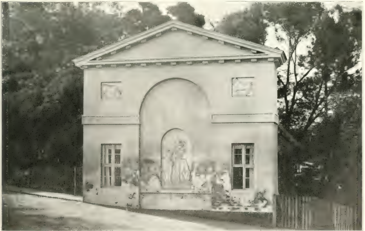
Chausseehaus (Kuhhaus) bei Dessau. Erdmannsdorff 1796.
